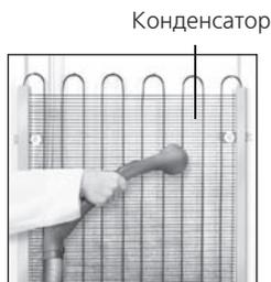
**Рисунок 10 — Уборка холодильника (вид сзади)**
